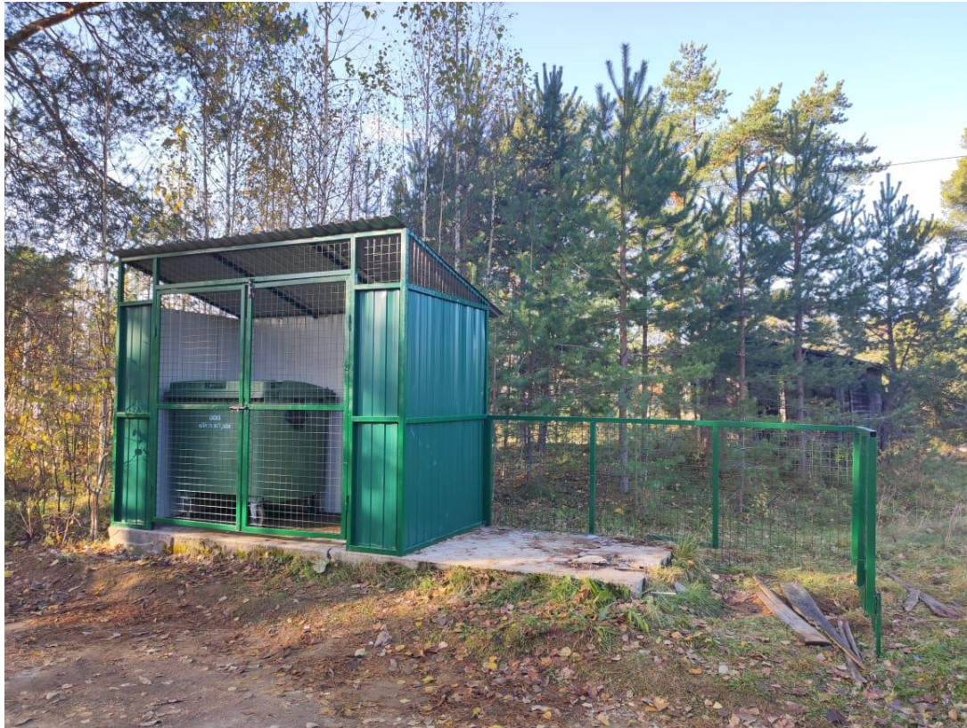
Отремонтирована контейнерная площадка в с. Крошнозеро
