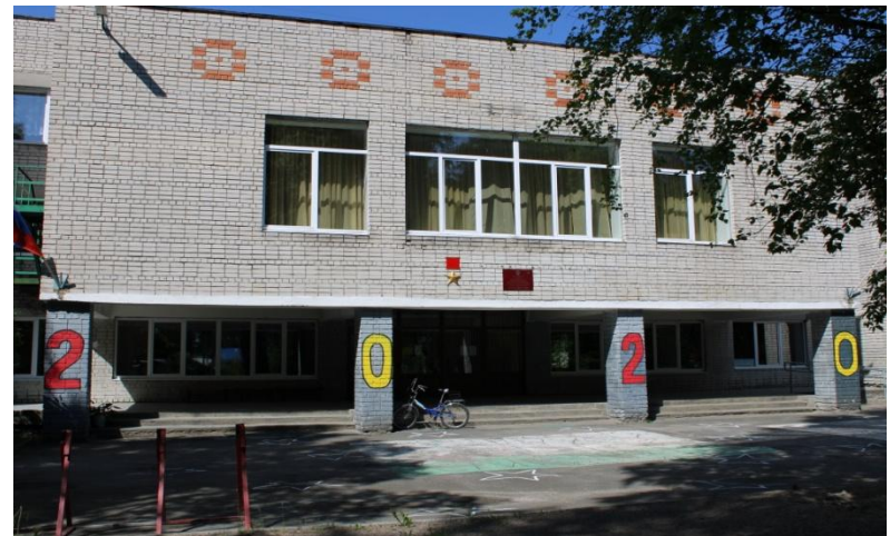
Фото до капитального ремонта
