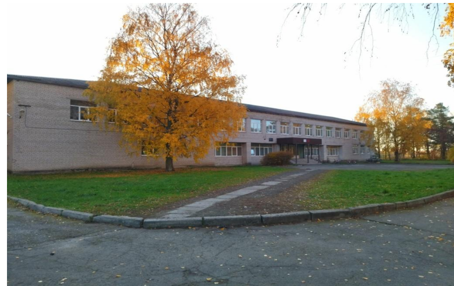
Фото до капитального ремонта
