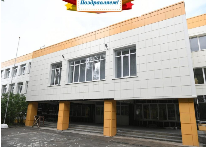
Фото после капитального ремонта
