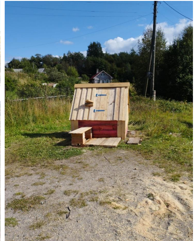
Отремонтирован колодец в с. Ведлозеро
