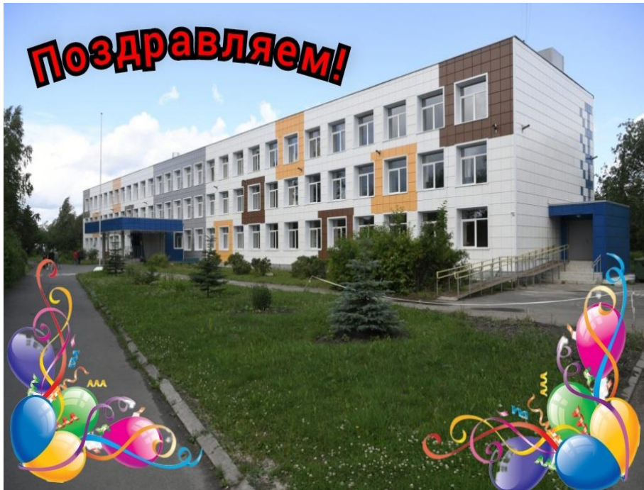
Фото после капитального ремонта
