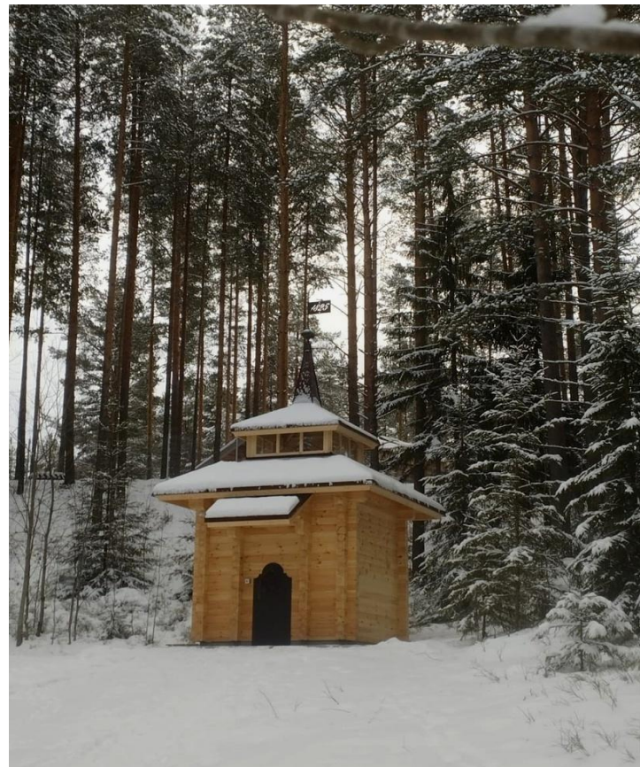
Фото после ремонта
